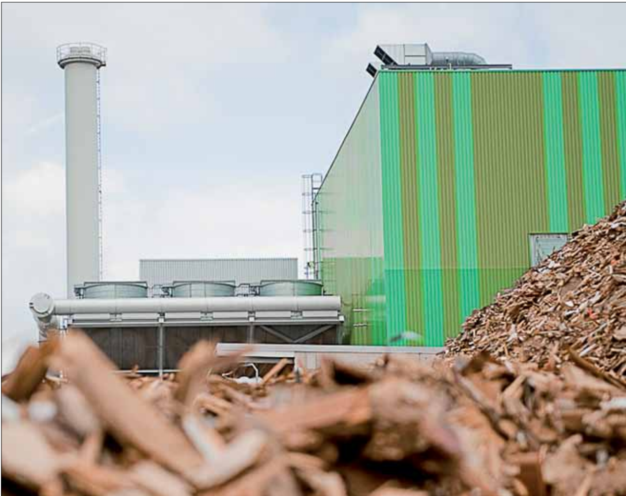
Bild 1. Biomasseheizkraftwerk in Oberhausen-Sterkrade
